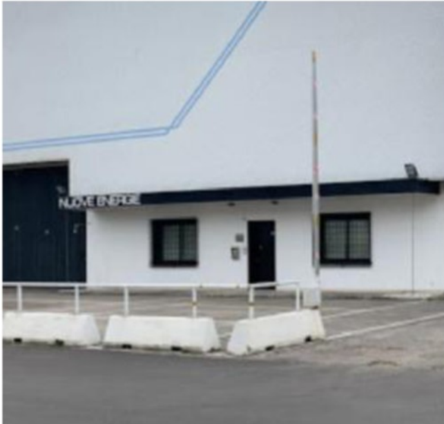
Nuove Energie di Vicenza realizza impianti per il trattamento delle acque
